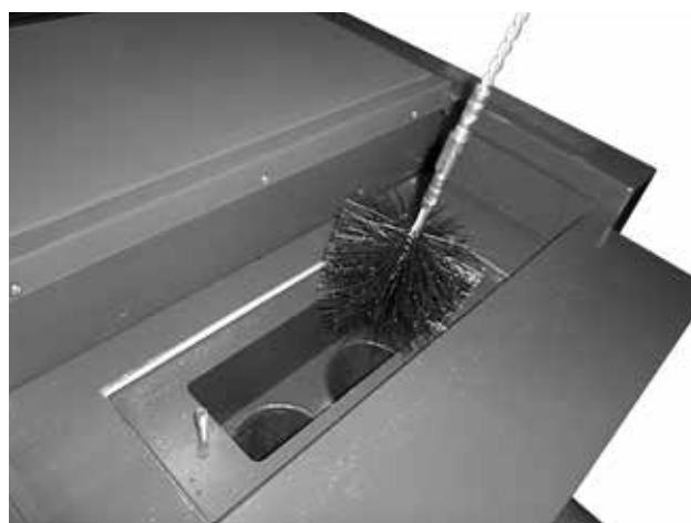
Dokładne wyczyszczenie wymiennika rurowego (den sitowych) szczotką
